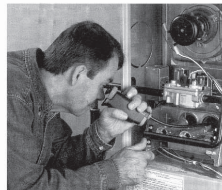
图22.用德图319检查和维护加热单元时不需要拆开
