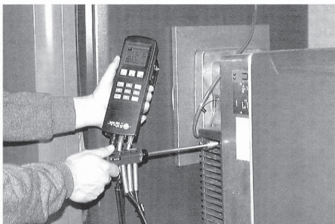
图12. 测量环境空气温度
